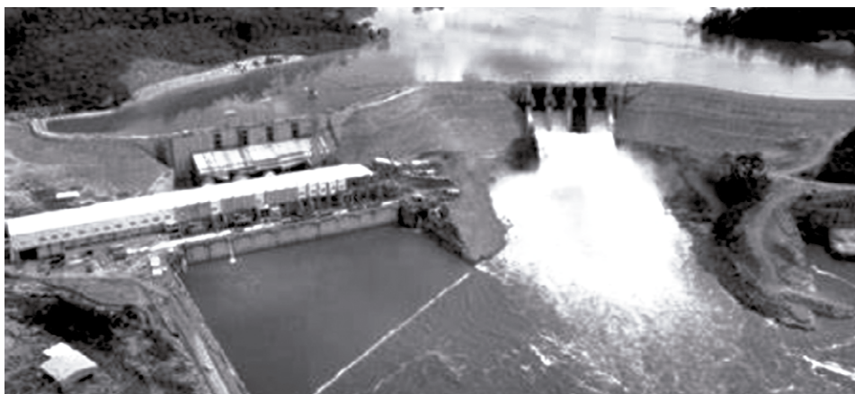
Construção da Hidrelétrica do Funil
