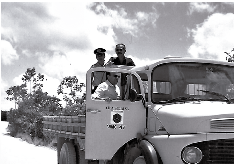
O governador Gilton Garcia acompanha o início da construção da estrada Macapá-Laranjal da Jari (1990).
