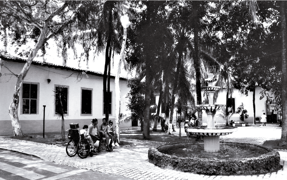
Centro de Reabilitação Integral Dom Aquino Correia
