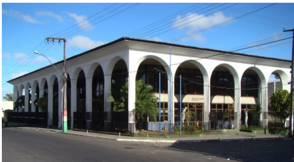
Edifício Nelson Pinto de Mendonça – Banco do Nordeste do Brasil – Inaugurado em 06 de janeiro de 1985
