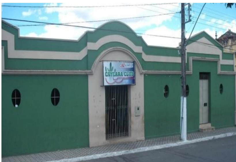
Fachada do antigo Mercado após a restauração e reinauguração do “Caiçara Club”. Acervo particular de Daniela Santos Silva Soares
