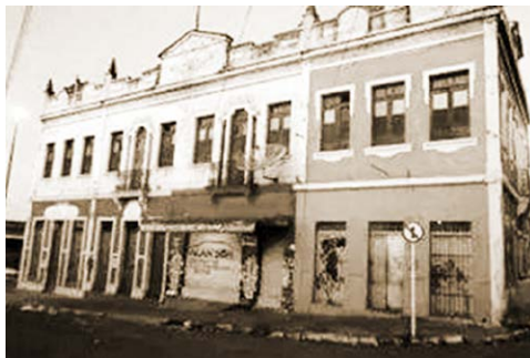
Foto do prédio da Associação Recreativa Cavaleiros da Noite Propriá-SE.
